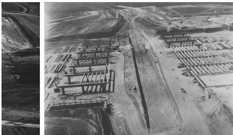
Montagem do sistema principal com anexação de vigas transversais aos pórticos para contraventamento e apoio da laje. Fonte: Arquivo Público do Distrito Federal.
