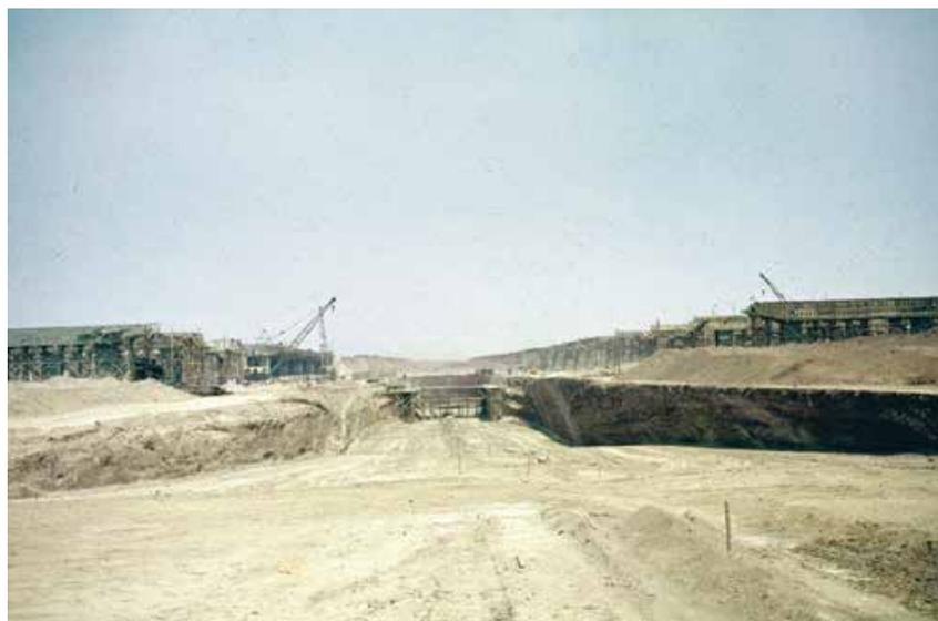
Escavação do “buraco do tatu”. Este corte delimitou o trecho onde hoje se instala a via de tráfego direto do eixo residencial que atravessa a Plataforma sem paradas. Observa-se a implantação dos primeiros pórticos da estrutura da Plataforma. Fotografia: Mario Fontenelle. Fonte: Arquivo Público do Distrito Federal.
