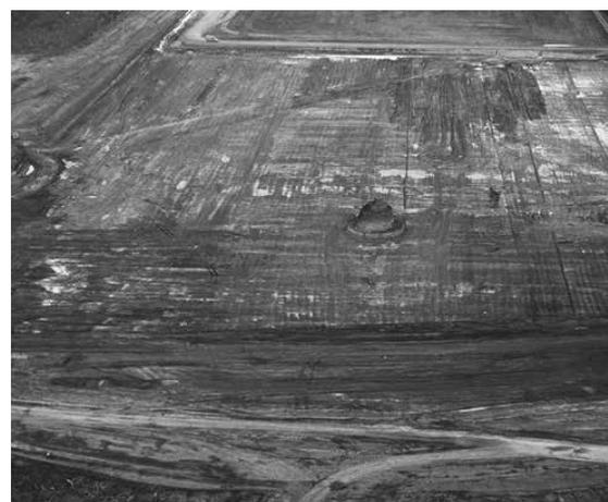
Corte de tierra delimitador del eje monumental, que conformaría los límites de la Plataforma con relación a este eje. En la imagen se pueden observar los muros de tierra resultantes de esta operación que luego sufrieron contención en hormigón armado y revestimientos. Fuente: Archivo Público del Distrito Federal.
