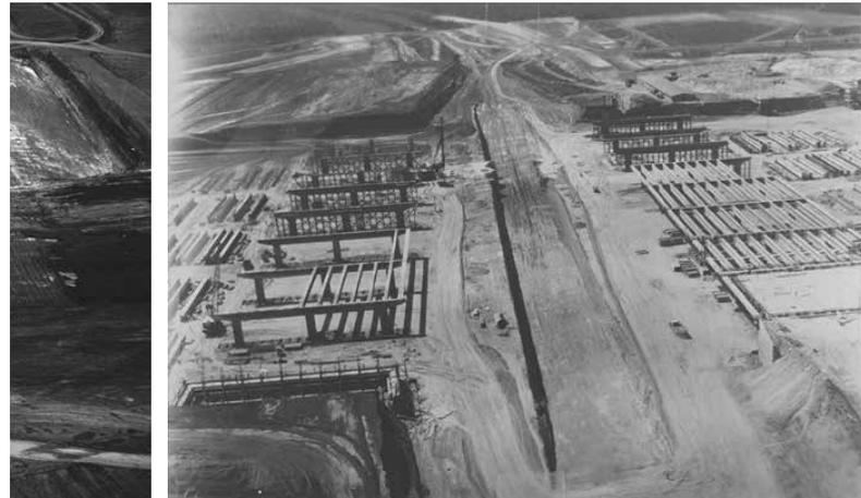
Montaje del sistema principal con agregado de vigas transversales a los pórticos para contraventamiento y apoyo de la losa. Fuente: Archivo Público del Distrito Federal.
