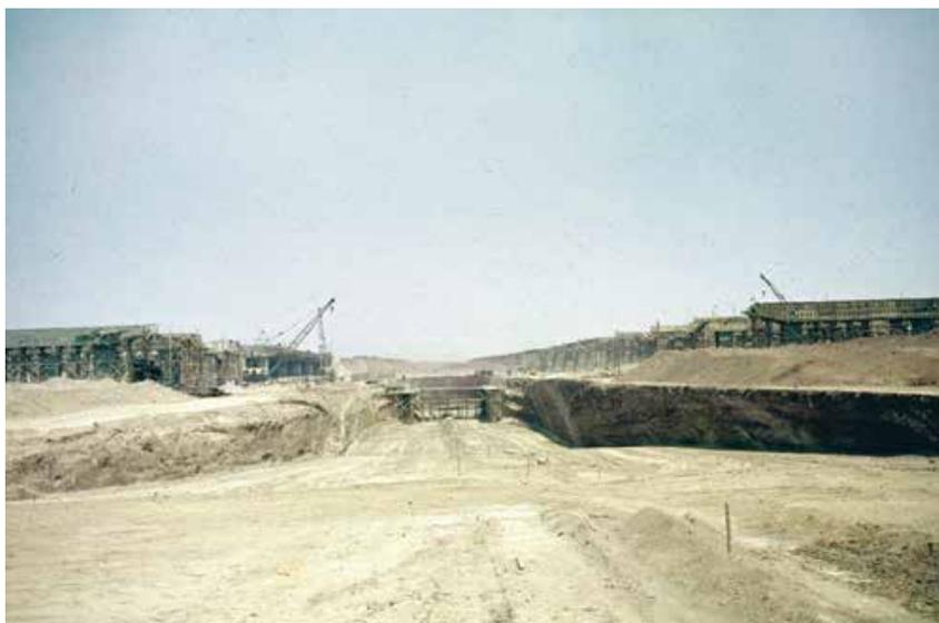
Excavación del "buraco do tatu". Este corte delimitó el tramo donde hoy se instala la vía de tránsito directo del eje residencial que atraviesa la Plataforma sin paradas. Se observa la implantación de los primeros pórticos de la estructura de la Plataforma. Foto: Mario Fontenelle. Fuente: Archivo Público del Distrito Federal.
